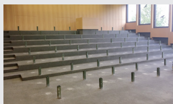
Demontage und Neumontage
